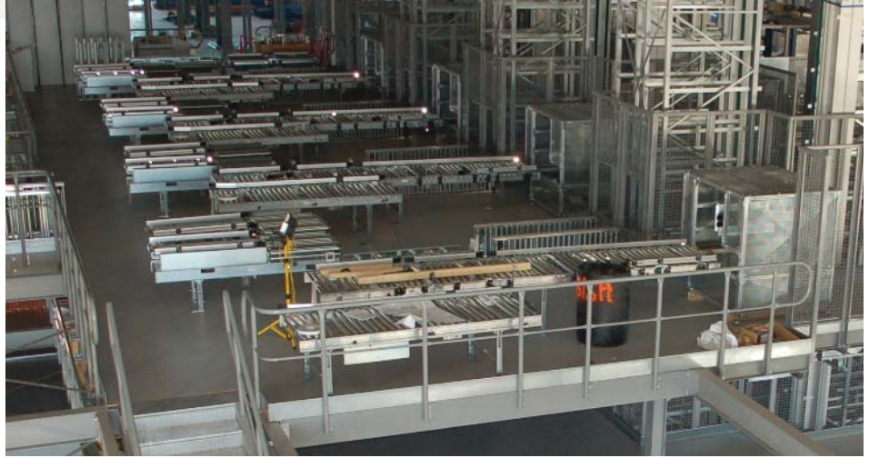
12,000 metros cuadrados (130,000 pies cuadrado) de ResinDek ® LD50 instalado en un almacén en Canadá.
